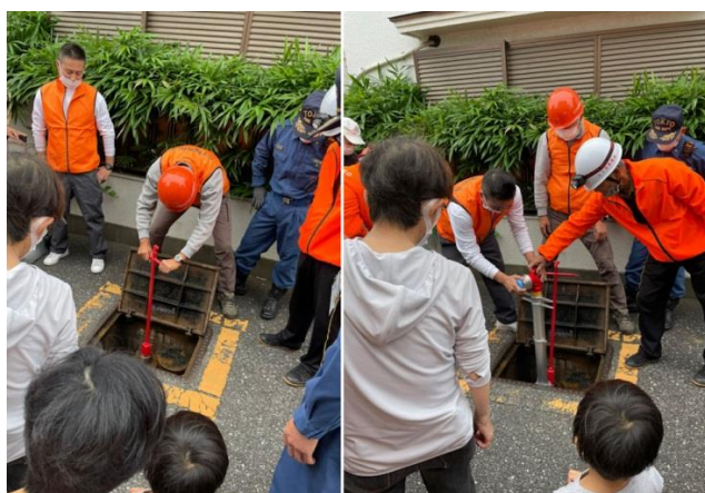
消火栓蓋開けからスタンドパイプの設置
