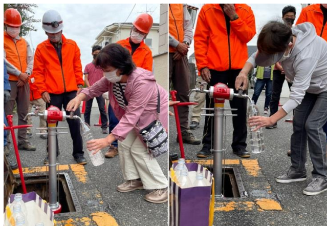
給水栓の蛇口をひねり給水を確認
