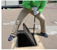
消火栓蓋を開放
