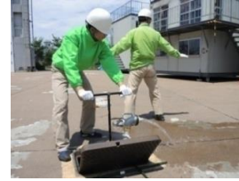
水が出るかの確認
