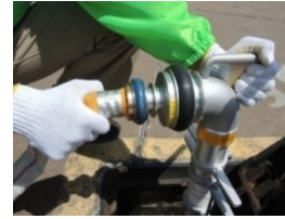
1本目ホースをスタンドパイプ
