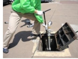
スピンドルを吐水弁に差し込む
