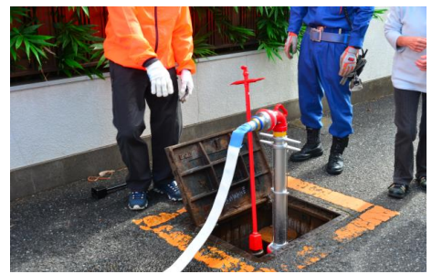
スタンドパイプセット完了
