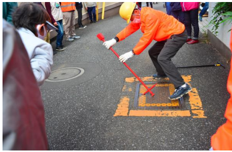
隊員による消火栓蓋開け
